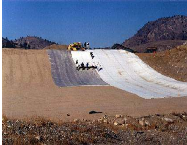
Слика 5.6. Постављање геомембране и геотекстила
