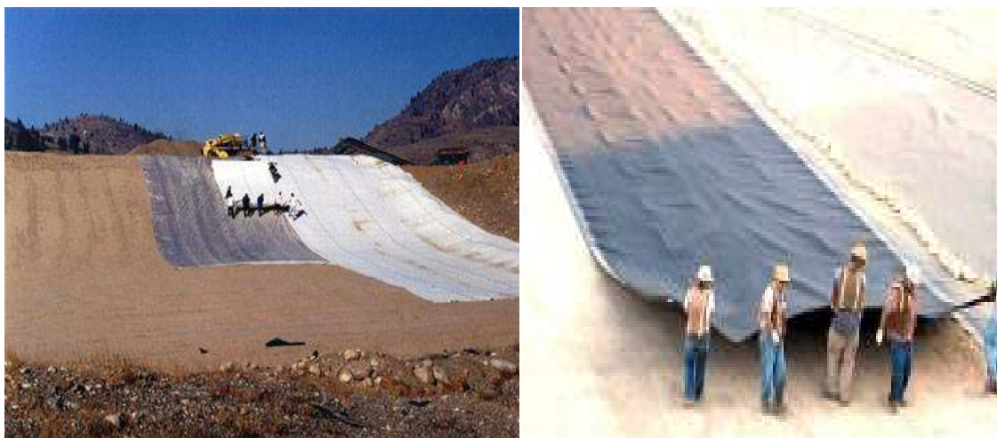
Слика 5.22. Постављања доње непропусне фолије.
