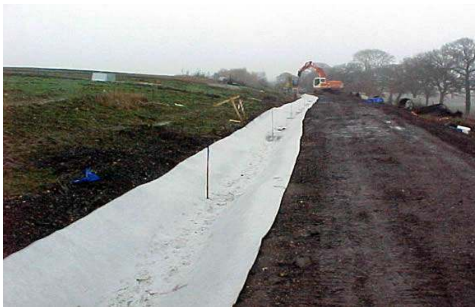
Слика 5.20. Приказ депоније са ободним каналима за отицање воде са фолије
